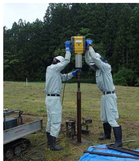
写真 1.1 打撃式簡易ボーリングマシンによる掘削
