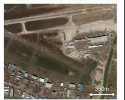
被災後（平成23年3月13日撮影）
