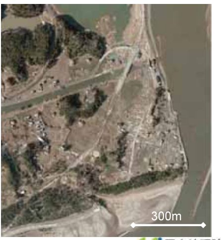
被災後（平成23年3月12日撮影）
