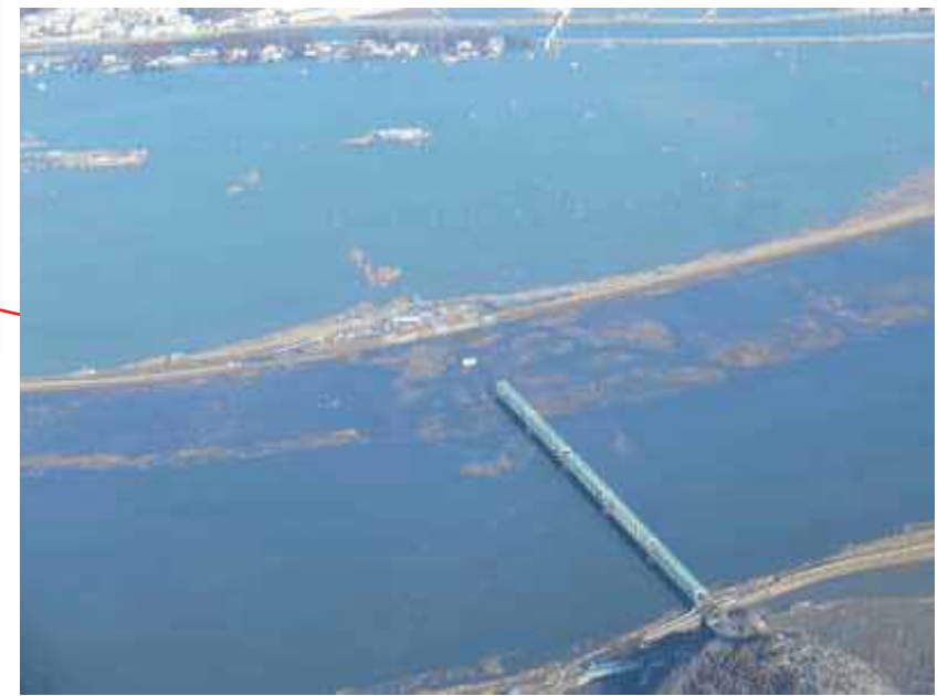
国道398号新北上大橋
