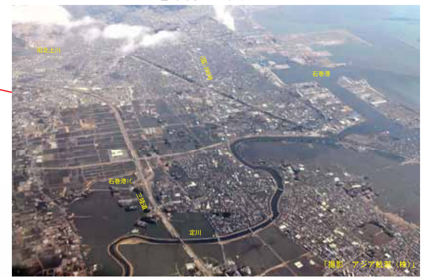
石巻市街地の被災状況
