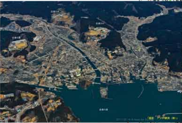
南三陸町 志津川周辺の被災状況
