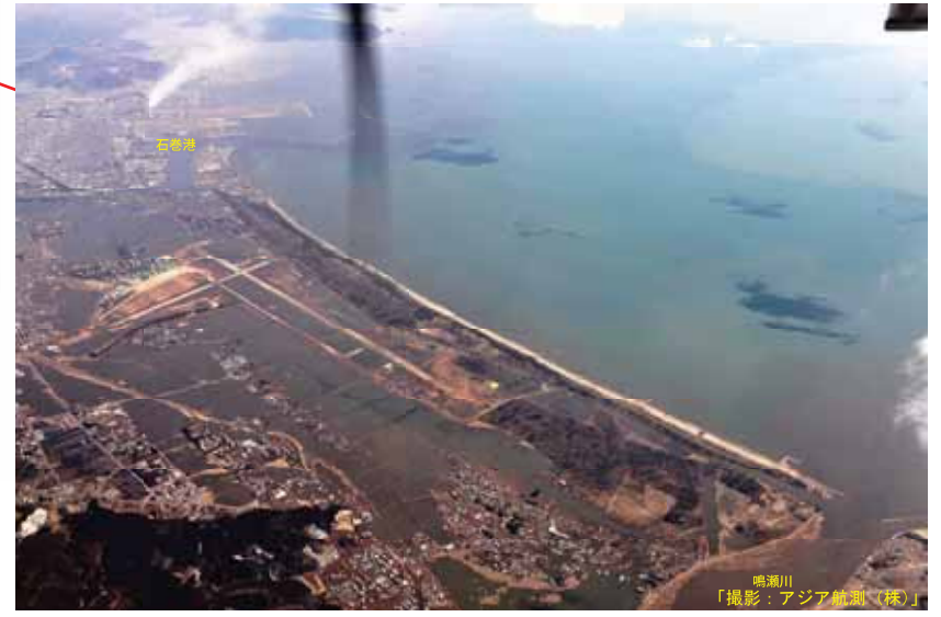
東松島市矢本の被災状況
