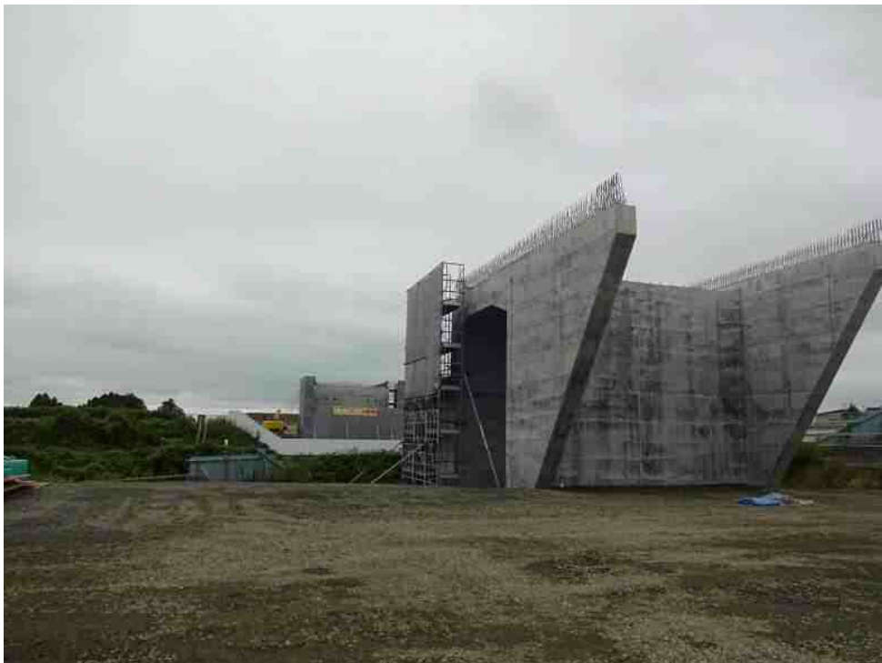
後沢本線橋 下部工 施工状況 (東北自動車道横過部)
