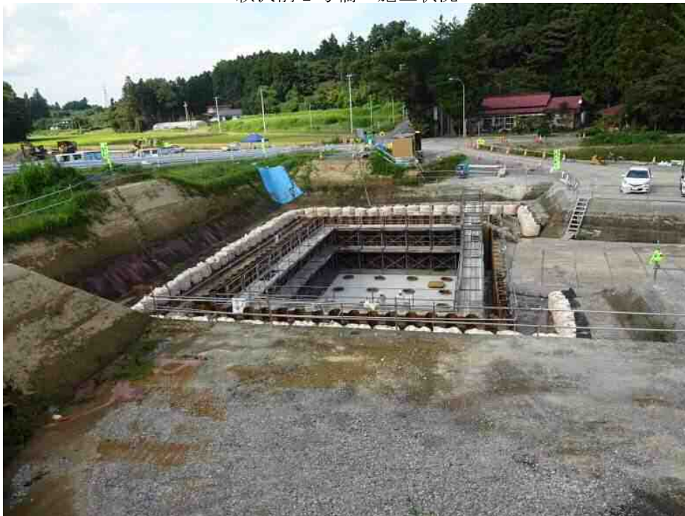
萩沢忽滑沢本線橋 下部工 施工状況
