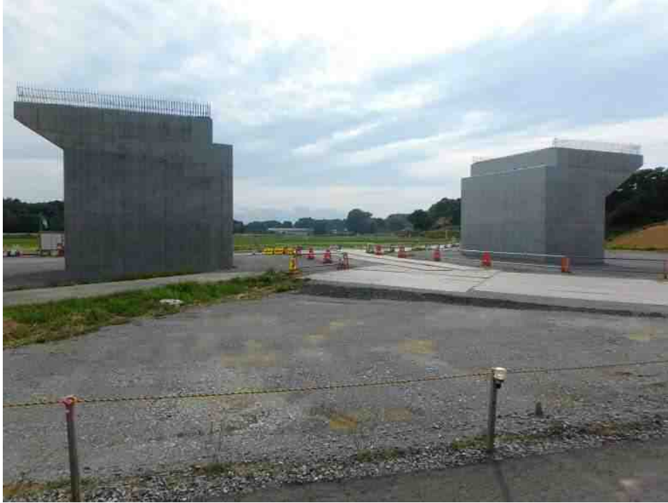
萩沢前1号橋 施工状況
