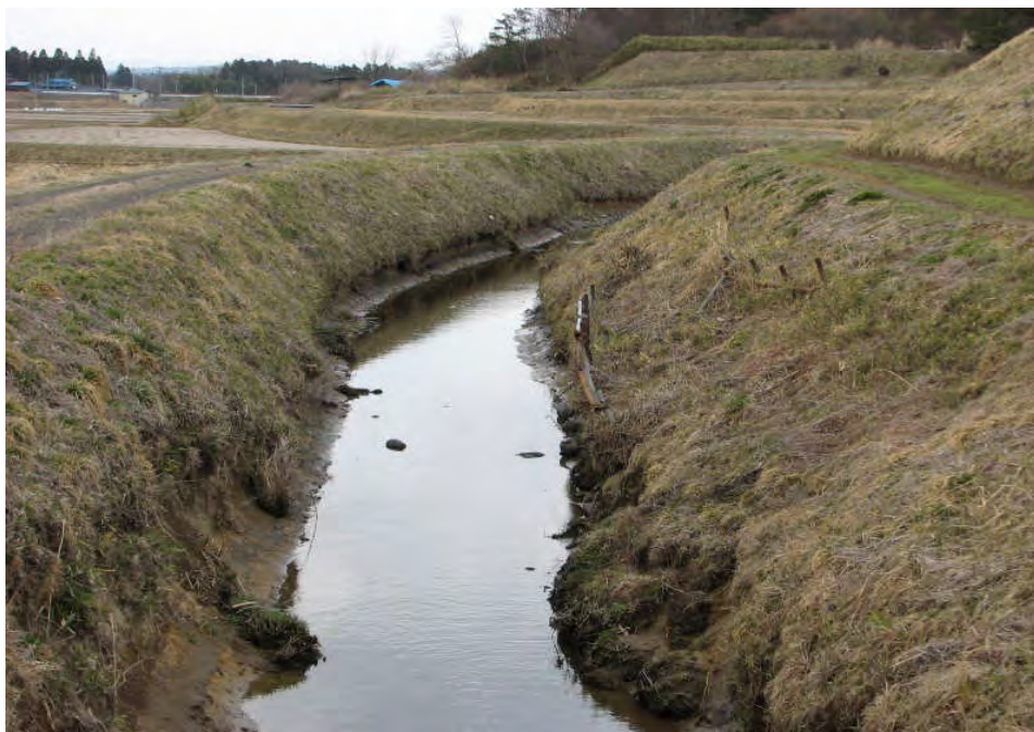
③ 上沼用排水路(未施工: NO.82付近 から下流)
