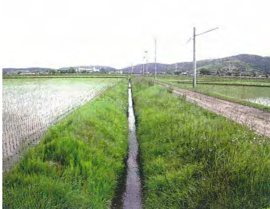
支線道路,排水路
