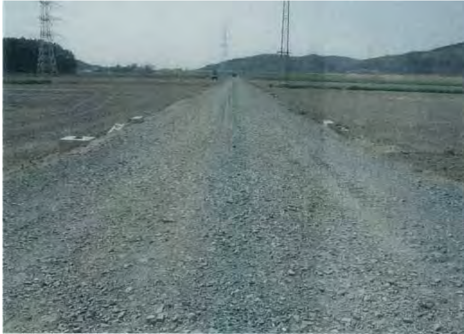
支線道路工, 用水路工(パイプライン給水栓)
