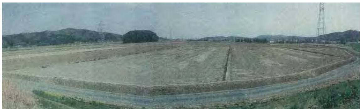
区画整理工(整地工)
