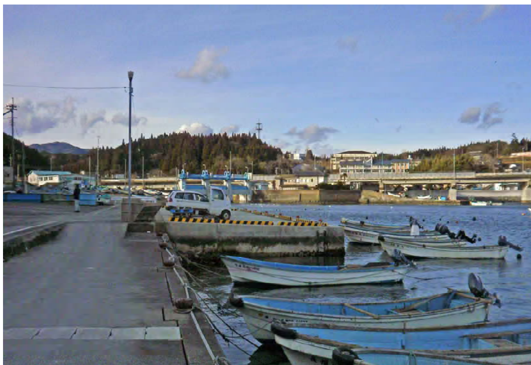
－ 2. 0 m物揚場 改良後
