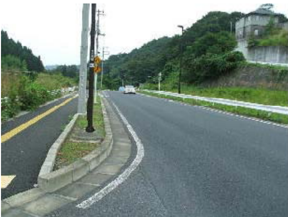
供用済接続部
