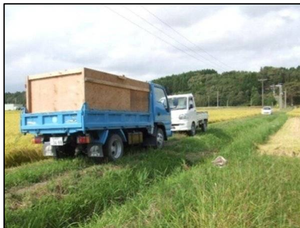
農道の幅員が狭いため、営農車両のすれ違いが困難で、効率的な営農に支障をきたしている。
