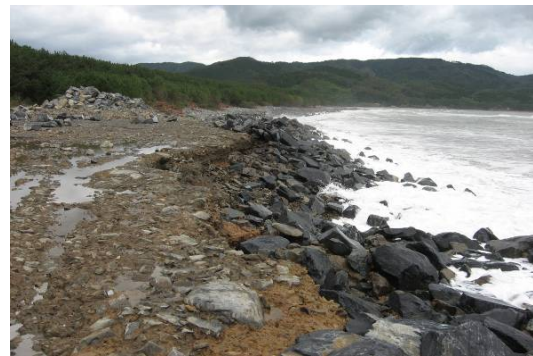
捨石護岸工の被災状況(駐車場部)
