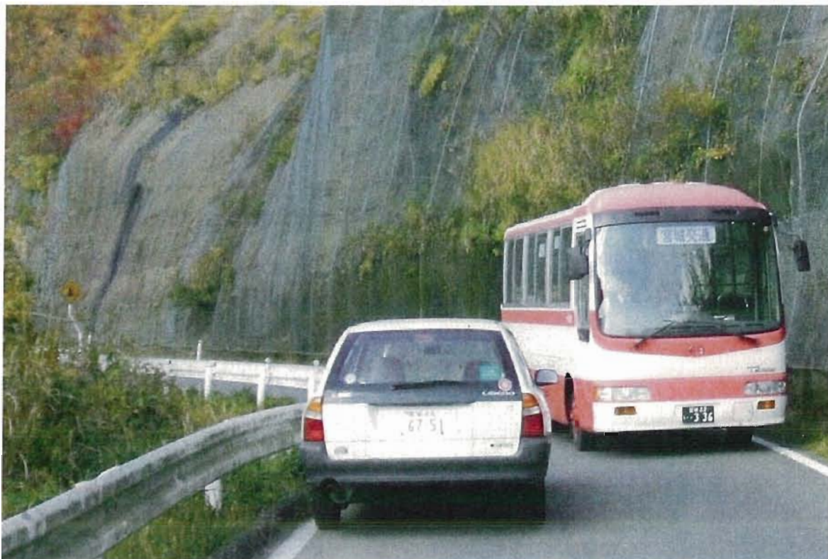
▲ 幅員狭小によるすれ違い困難状況
