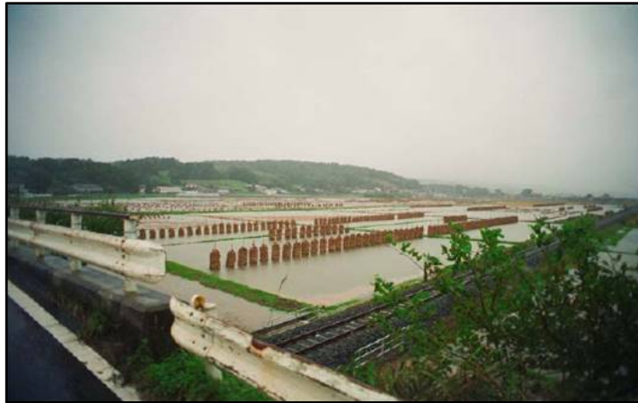
湛水被害の状況 (平成3年10月)
