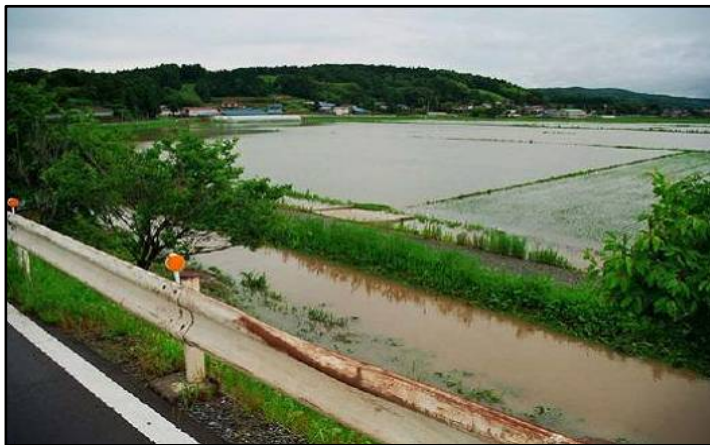
湛水被害の状況 (平成9年6月)
