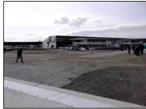
B棟建設場所
