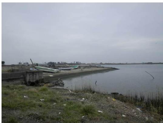
広浦船揚場（工事着手前）
