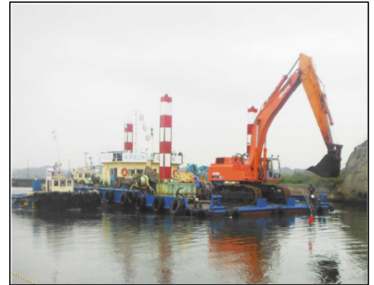
バックホウ台船による撤去作業
