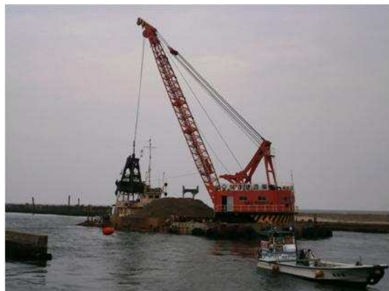
浚渫工事の様子
