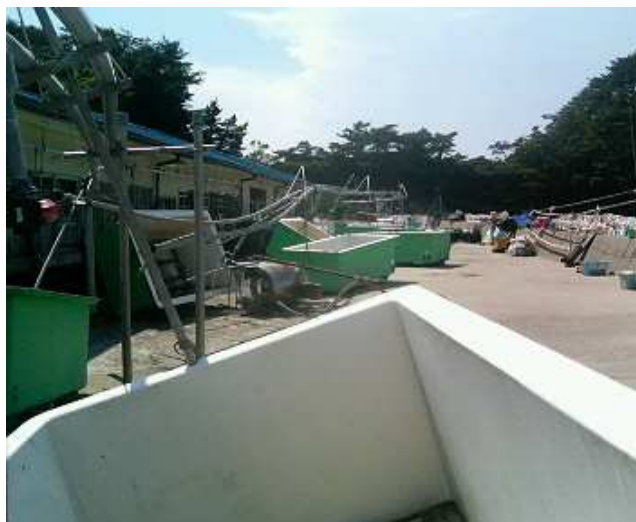
津波被害を受けた野々島のカキ浄化施設
