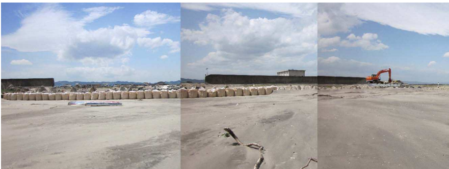
荒浜漁港海岸応急復旧工事状況（H23.5.13現在）
