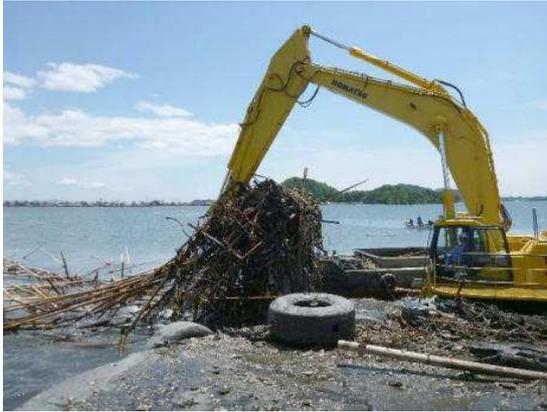
バックホウ台船による作業状況
