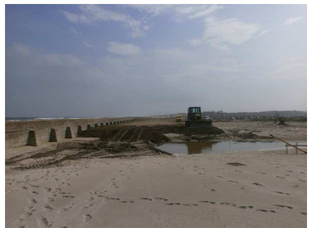
深掘れ箇所埋め戻し作業
