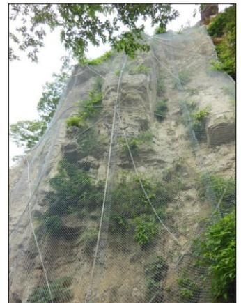
土石とともに巨大な石が落下し下方の林道が通行できなくなり、一時住宅を孤立させた箇所。金網により落石の落下エネルギーを減衰させる工法を採用。(仙台市青葉区熊ヶ根地内)
