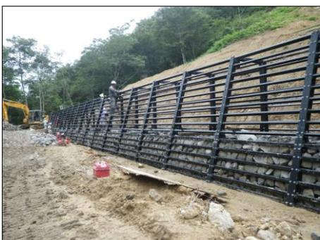
急斜面上部が大規模に崩壊し下方にあった森林をなぎ倒した箇所。鋼製の土留めにより崩れた土砂を抑えて安定させます。(仙台市青葉区新川地内。施工中)
