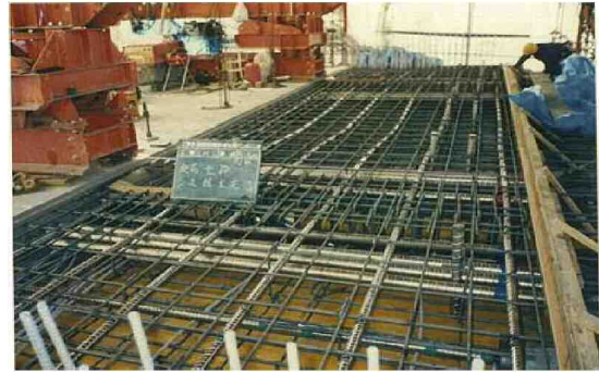
当初: 現場打ちPC床版
