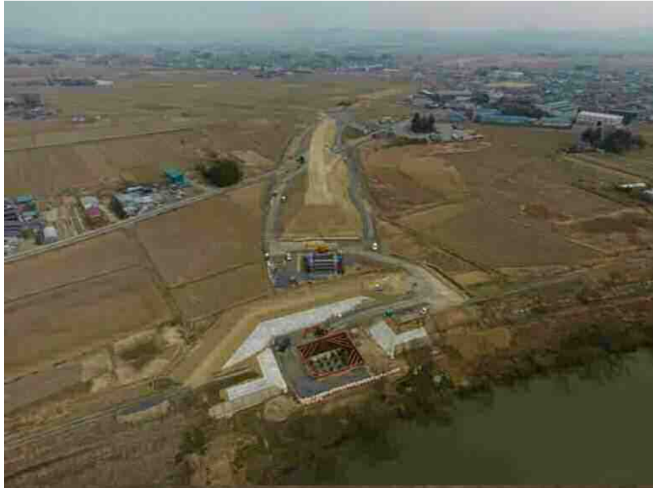
紫雲山大橋（迫川左岸）架橋予定位置
