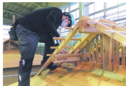
高技専の実習では実物大の家屋を製作し、家の各部分や名称、家が建つまでの流れなどを実践を通して習得。
