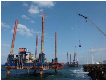
海底面の障害物撤去とモノパイル打設
