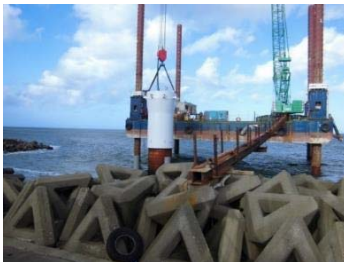
ジョイントスリーブ（接合部）の設置
