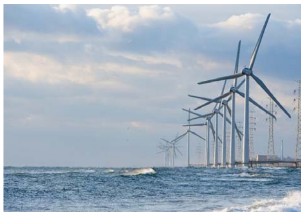
ウィンド・パワーかみす第2洋上風力発電所
