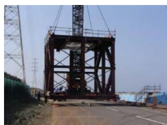
モノパイル打設用導枠
