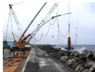
モノパイル打設状況 (750tクレーンで施工、500tハンマーで打設)
