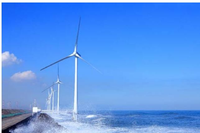
ウィンド・パワーかみす第1洋上風力発電所
