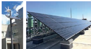
施設には太陽光パネルのほか、太陽光・風力ハイブリッド街路灯、電力表示パネルも設置されています。
