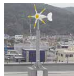
鳥避け用風力発電設備
