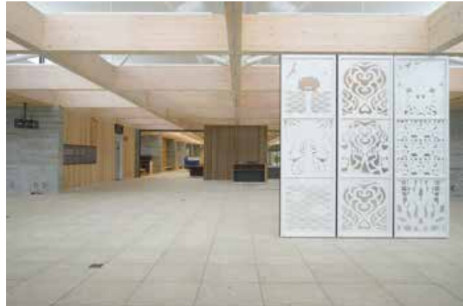
各種イベントでも利用可能な町民交流スペース「マチドマ」冬期はペレットボイラーによる床暖房で足元を暖めています。
