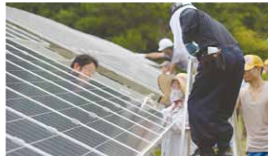
太陽光パネル設置の様子
