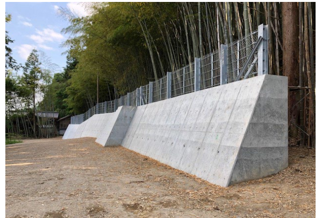
待受け式擁壁工法
