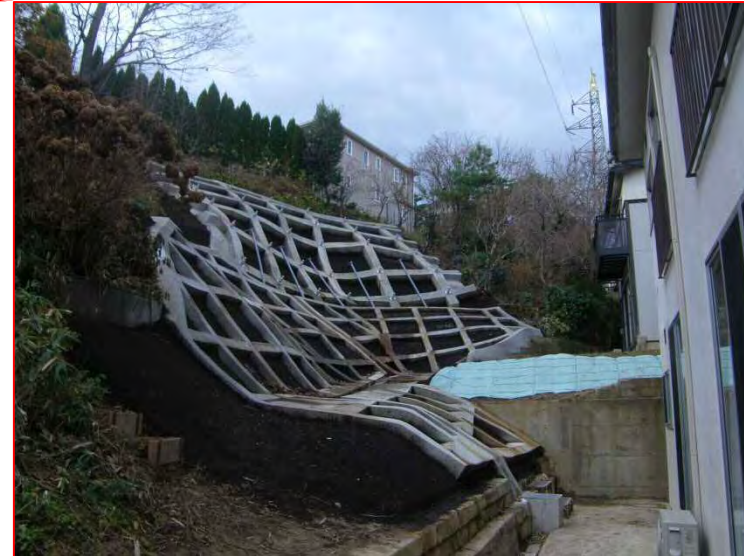
コンクリート フリーフレーム により斜面崩壊を抑制
