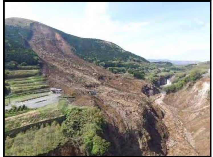
熊本島県南阿蘇村で発生した 土石流 2016年4月
