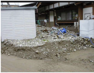
土砂災害により被災した住宅 (下呂市萩原町)
