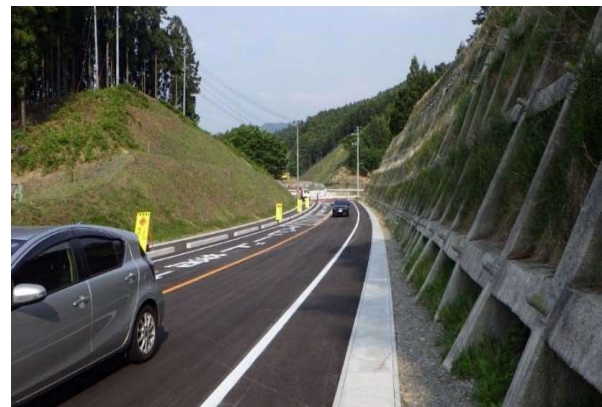
▲ (主) 石巻鮎川線(風越 2 工区)
