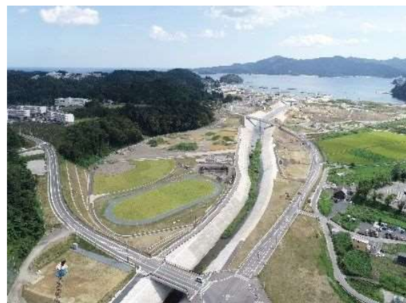
▲ (国) 398号(志津川工区)
