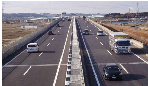
▲ 三陸沿岸道路 4車線化 (仙台港北 IC～利府中 IC)
