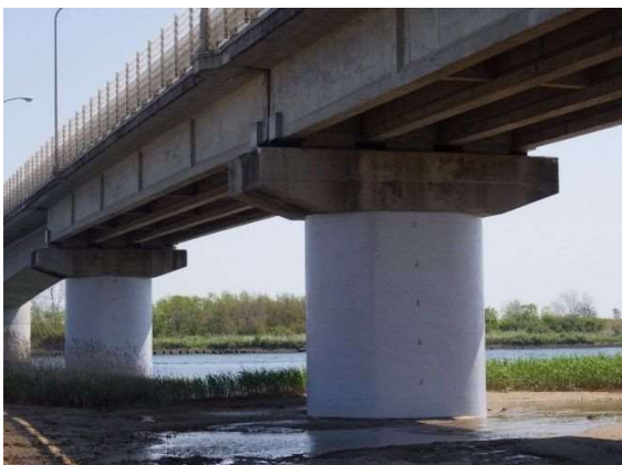
▲（主）塩釜巨理線（閑上大橋）耐震補強事例
