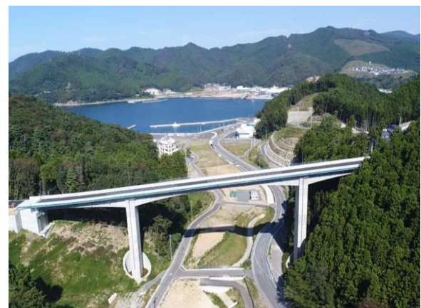
▲ (主) 女川牡鹿線(小乗浜工区)
