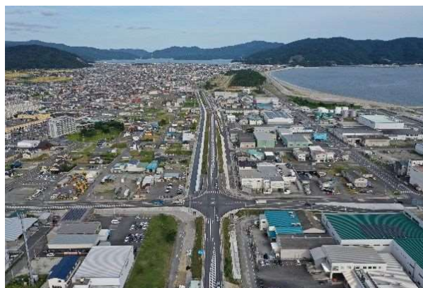
▲ （都）門脇流留線（魚町工区）
