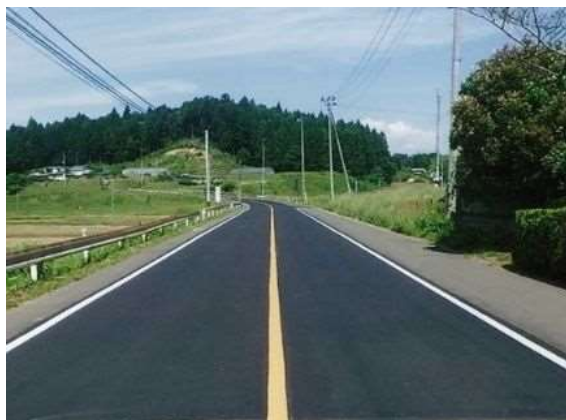
▲（国）113号 舗装補修事例
