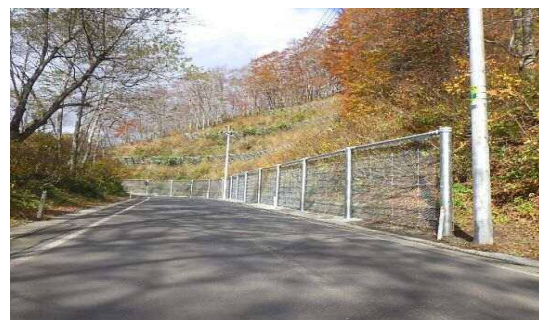
▲ せり出し防護柵の整備 [(国)347号 鍋越(加美町)]
