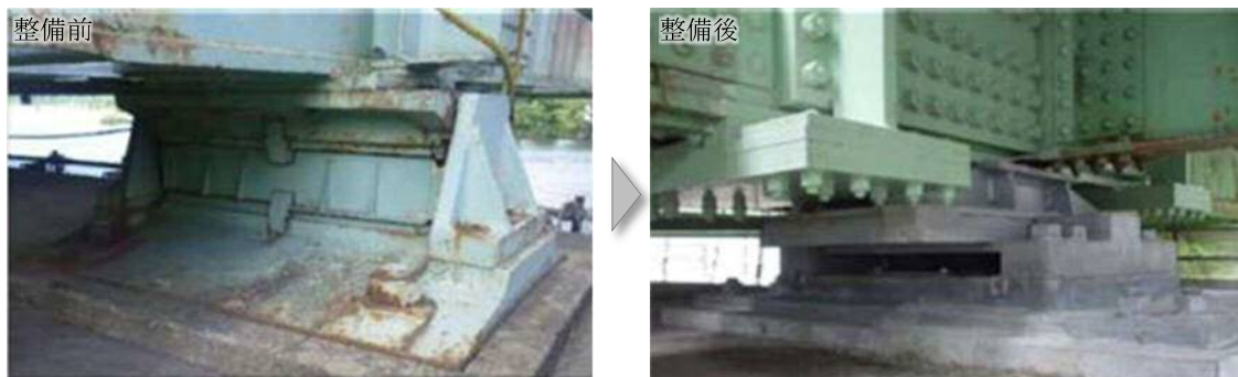
▲ 支承交換の実施 [(主)涌谷津山線 柳津大橋 (登米市)]
