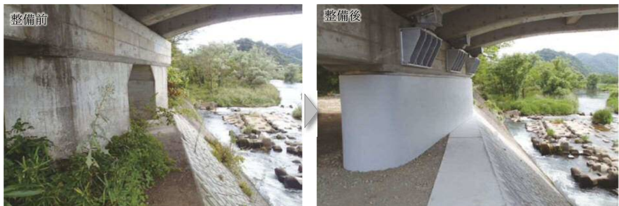
▲ 橋脚巻き立ての実施 [(主)岩沼蔵王線 宮大橋 (蔵王町)]
