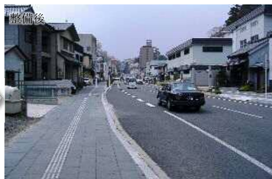
▲ 道路拡幅・無電柱化（電線共同溝整備） 〔（都）北浜沢乙線（塩竈市）〕
