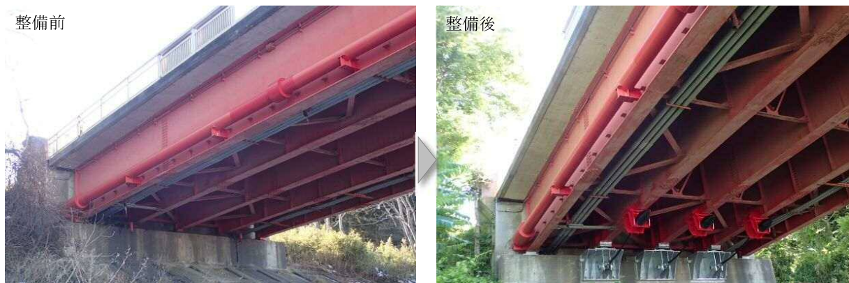
▲ 落橋防止の実施 [(国)346号 感恩橋 (大崎市)]
