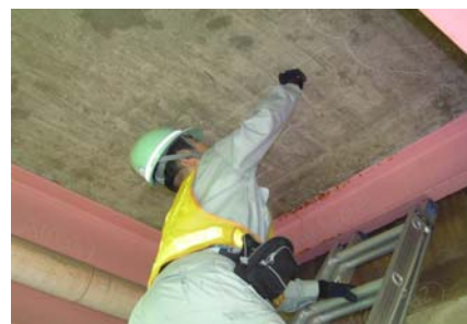
写真－1 橋梁点検の状況
