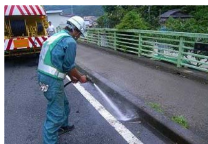
写真－2 排水樹の清掃状況
