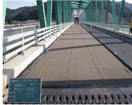
写真-4 床版防水工
