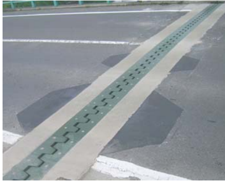
写真-3 非排水型伸縮装置
