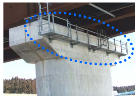
写真－3 下部構造検査路
