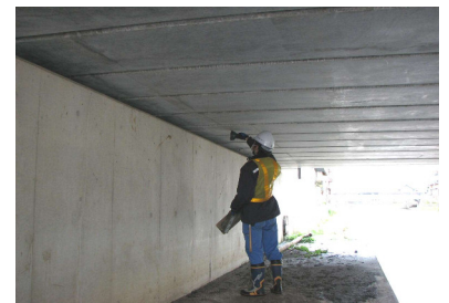
定期点検の状況
