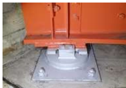
鋼製支承の金属溶射
