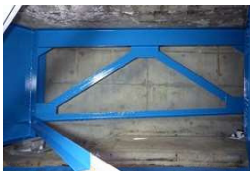
桁端部の重防食塗装
