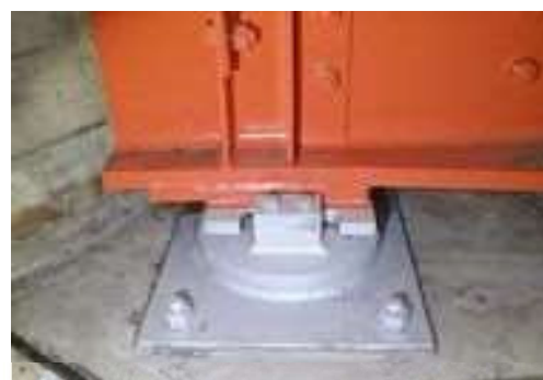
鋼製支承の金属溶射
