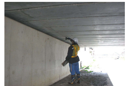
定期点検の状況
