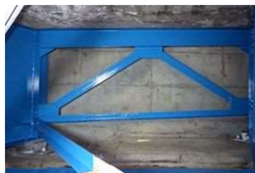
桁端部の重防食塗装
