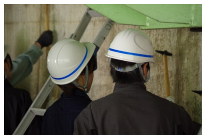
▲下部工の打音による点検状況
