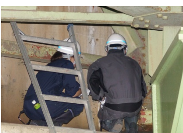
▲桁端部の腐食状況確認
