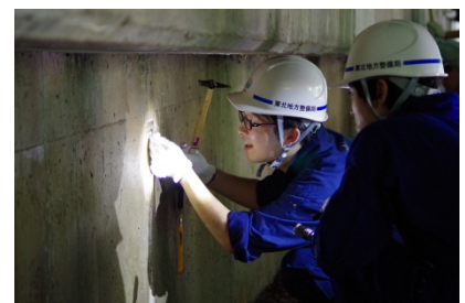
▲下部工のひび割れ幅測定状況
