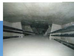
箱桁内部断面
