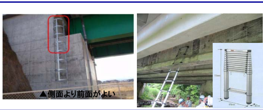
手摺、籠、鍵付きマンホールの設置。あるいは梯子の格納等を検討する。
