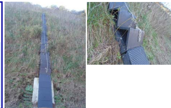
法面にロープ付き階段を設置した事例
