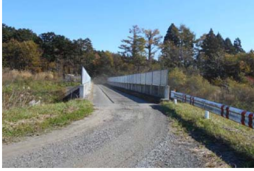
▼正面(橋面はAS舗装、前後砂利)
