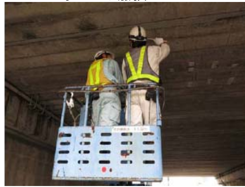
▼リフト車による点検
