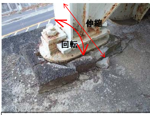
▼鋼製支承部(線支承)
