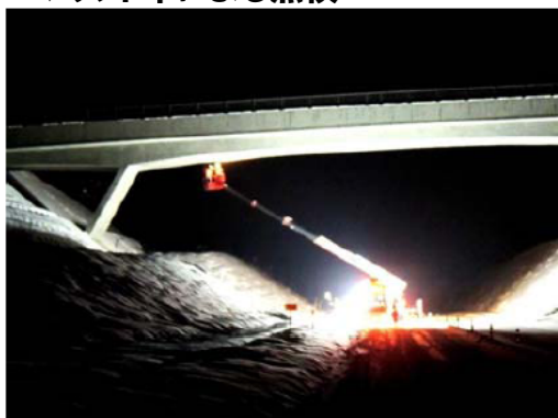
▼リフト車による点検
