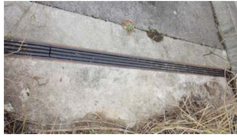
▼橋台部ゴム製伸縮継手
