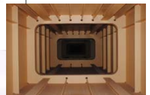
箱桁内部断面
