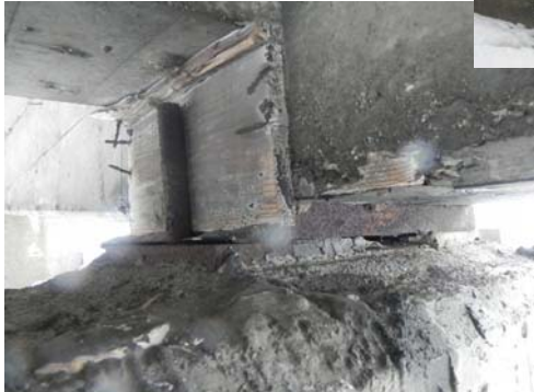
▼橋脚上の鋼製支承部
