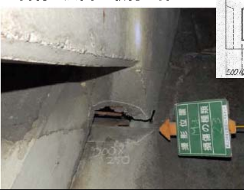
▼斜材と法面の取付け部
