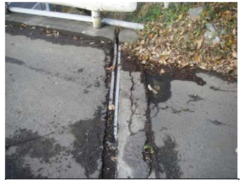
▼橋台部伸縮装置
