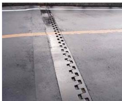
鋼製ジョイントの例(荷重支持型)
