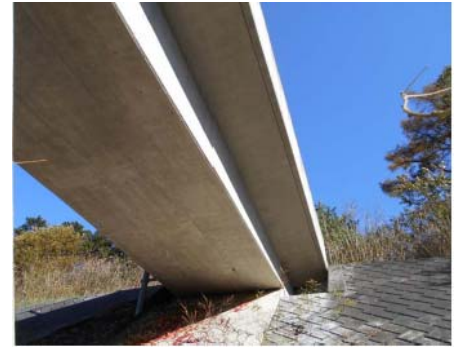
▼橋下と斜材、法面保護
