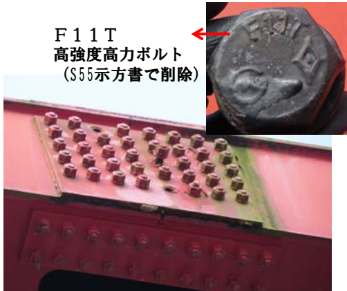
高力ボルトの破断脱落
