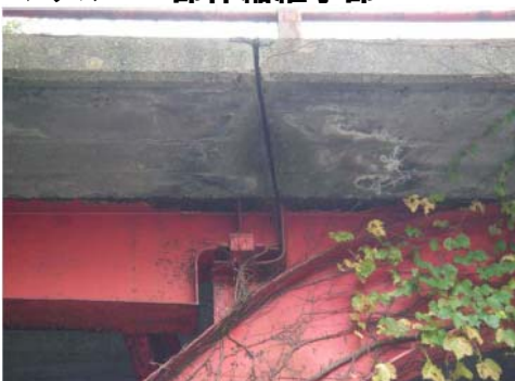
▼ゲルバー部伸縮継手部
