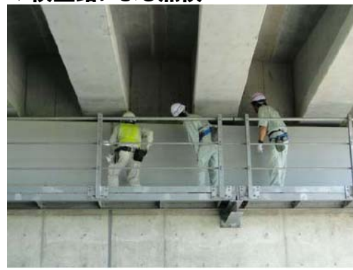
▼検査路による点検
