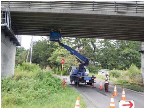
▼リフト車による点検
