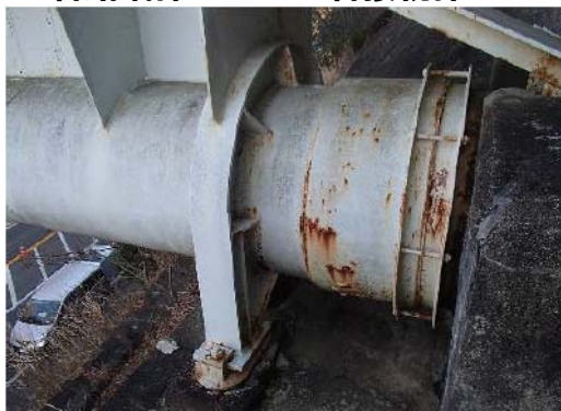
▼管路端部とヒューム管接続部
