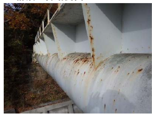
▼桁及び管路側面
