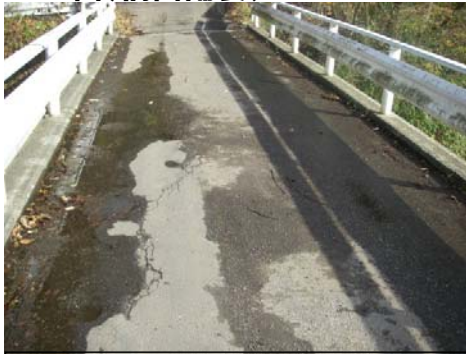
▼正面(橋面舗装)
