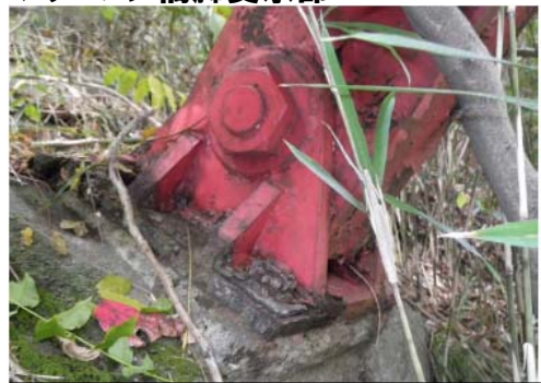
▼ラーメン橋脚支承部
