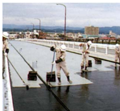
塗膜系床版防水層の塗布
