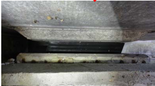
▼橋台部ゴム支承
