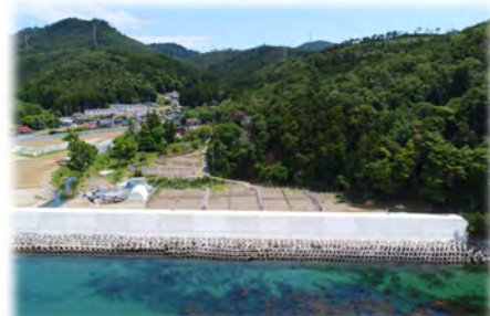
復旧した防潮堤
