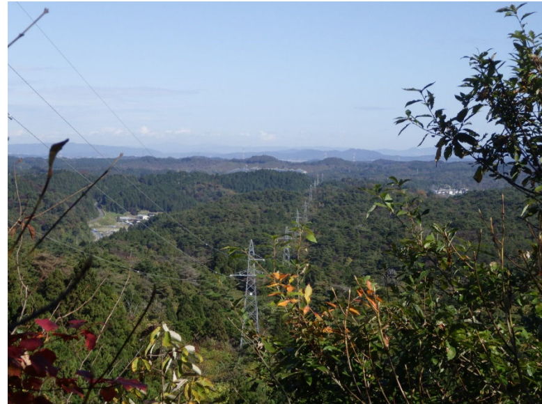
高圧線配置状況
