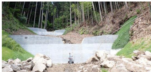
治山施設による山地災害の復旧
