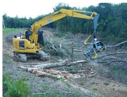
（一貫作業における機械地拵えの様子）
