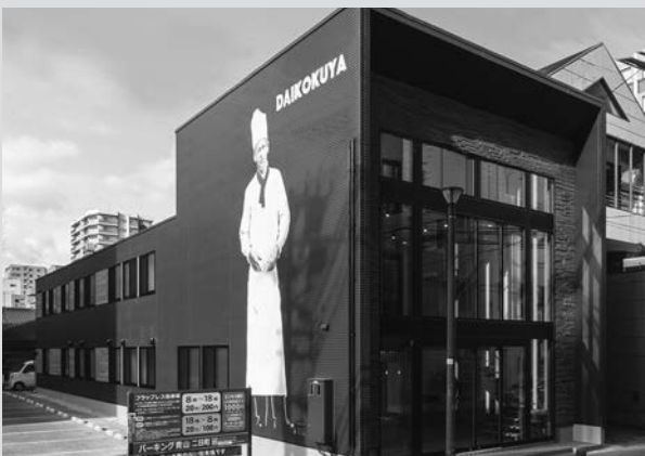
ひときわ目を引く外観で通行人の目に留まる建物
