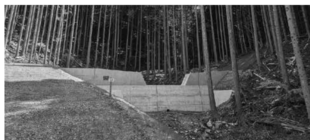
▲完成した谷止工(地切沢)
