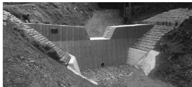
▲完成した谷止工(巳の口沢)
