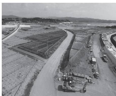
防災林造成工事の完了状況 (尾崎・千岩田)
