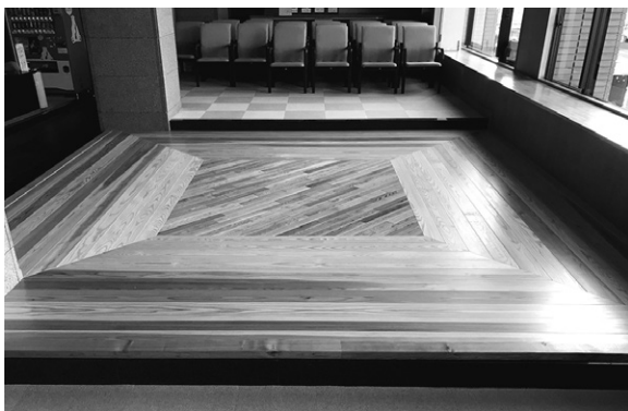
広葉樹フローリングのモデル施工
