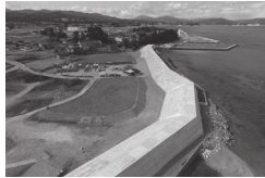
復旧工事が完了した気仙沼市波路防潮堤
