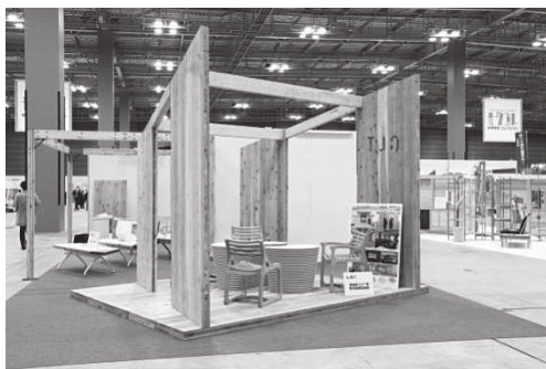
CLTやLVLを用いた躯体
