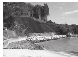
復旧工事が完了した海岸崖地(寄木)
