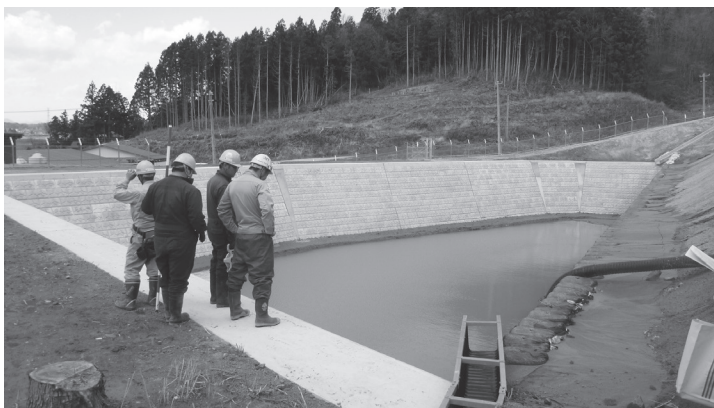
水害を防止するための調整池
