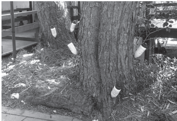
重要な松への樹幹注入実施状況
