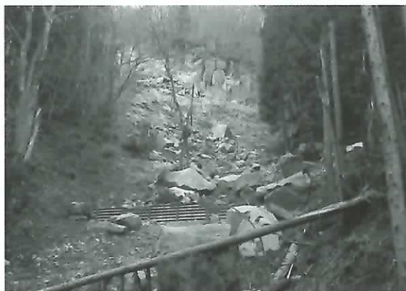
崩壊による巨石が下流に流出(大崎市)
