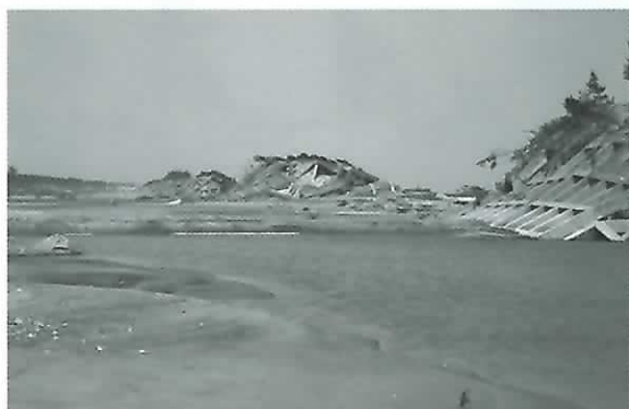
津波により決壊した防潮堤(山元町)
