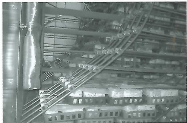
地震により、培養棚が倒壊
