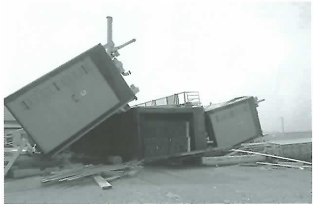
倒壊流出した木材乾燥機
