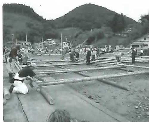
イカダの組み立て作業
