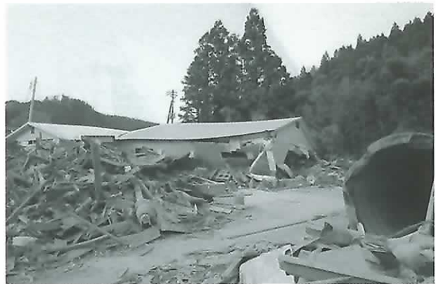
津波により、生産施設が倒壊
