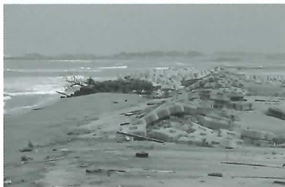
津波により消失した防潮堤(仙台市)
