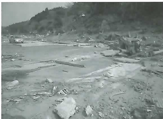
基礎部のみになった工場
