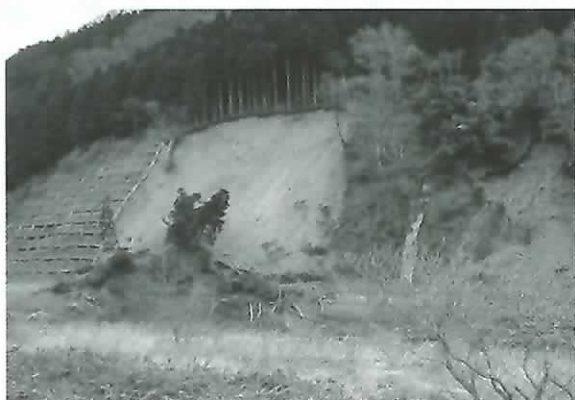
崩壊による土砂が河川に堆積(川崎町)
