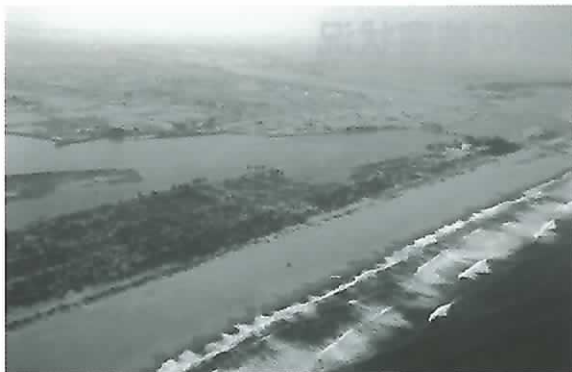
上空からの海岸林被災の状況(名取市)
