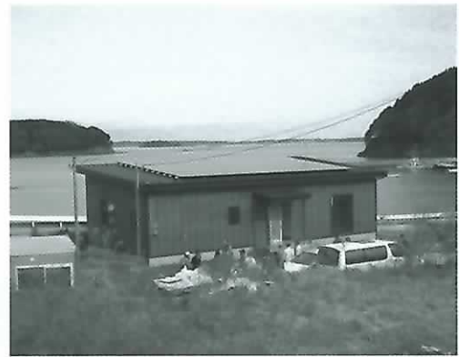
屋根に設置されたソーラーパネル
