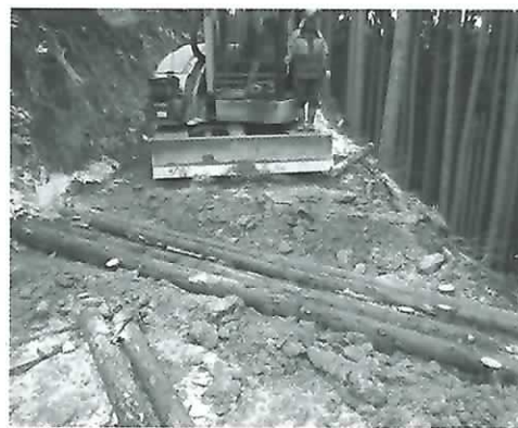
現地発生材活用の木製横断工
