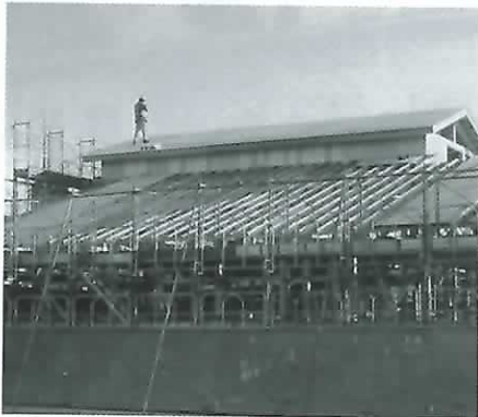
建築中のふだんに地域材を使った角田消防署丸森出張所
