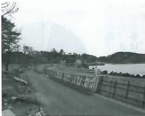
東松島市三サ河の施工状況 (堤防嵩上げ工事)
