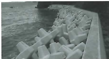
復旧した館浜防潮護岸工事
