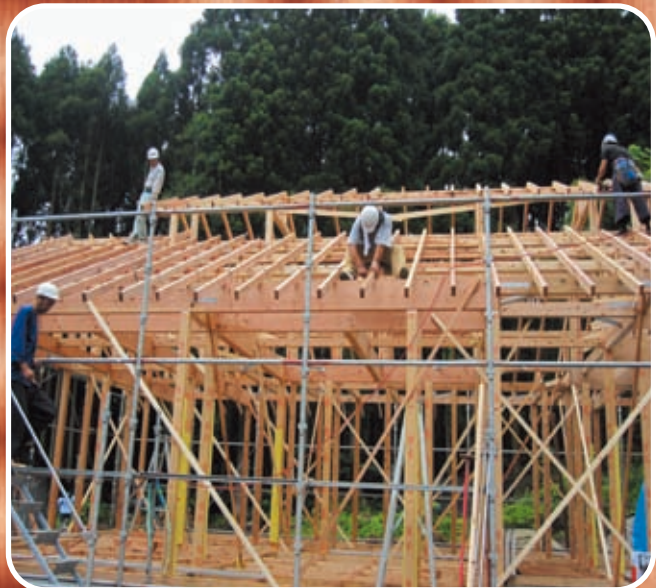
「県産材で家づくり緊急支援事業」上棟状況（栗原市）
