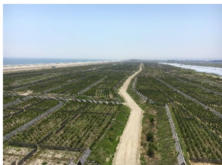
復旧が進められている海岸防災林
