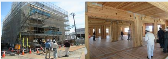
CLT施設の建設現場で管理者研修を実施
